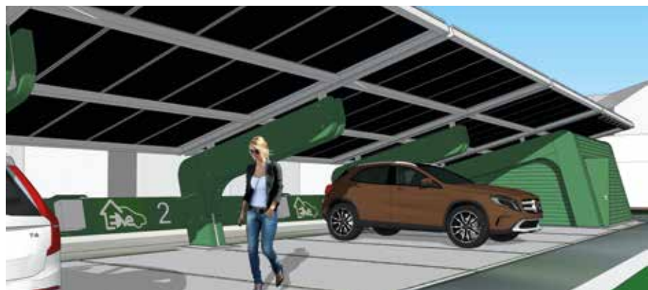
Arkitektbild på laddstationen i stadsdelen Rosta, den är byggd som en carport och har 16 laddplatser för elbilar. Laddstationen är försedd med solceller, eget batterilager och är förberedd för V2G. Örebrobostäder väljer att satsa på denna typ av laddplatser istället för att sprida ut laddstolparna.
