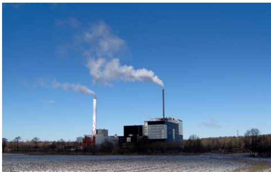
Figur 2. Kristineheds kraftvärmeverk i Halmstad försörjer 67 % av fjärrvärmens i Halmstad. Fjärrvärmens har ersatt tusentals oljepannor i staden. Enligt företaget HEM:s miljöredovisning 2019 undveks utsläpp av 187 300 ton CO 2 e tack vare fjärrvärmens.
