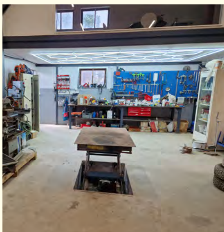
Interiör i en gårdsverkstad där led-ljusslingor, som ger mycket ljus till låg energianvändning, installerats i taket.
