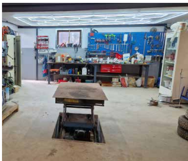
Interiör i en gårdsverkstad där LED-ljusslingor som ger mycket ljus till låg energianvändning installerats i taket.
