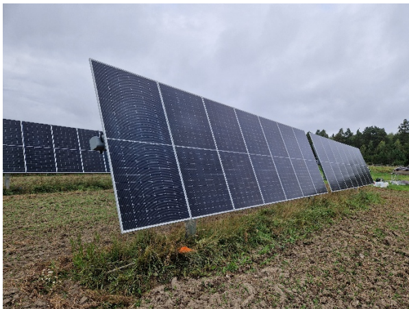
Solcellspaneler upphängda på en horisontell axel och med styrning i en rikning så att de kan följa solens höjd över horisonten. Studerade av MDU och SLU i samarbete.
