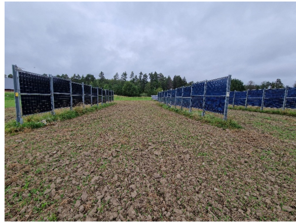
Två-sidiga, stående och fast monterade, solcellspaneler som möjliggör att jorden kan brukas emellan dessa. Studerade av MDU och SLU i samarbete.
