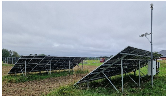
Konventionella solcellspaneler med fast lutning och riktade mot söder. Studerade av MDU och SLU i samarbete.
