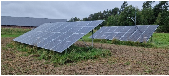
Konventionella solcellspaneler med fast lutning och riktade mot söder. Studerade av MDU och SLU i samarbete.
