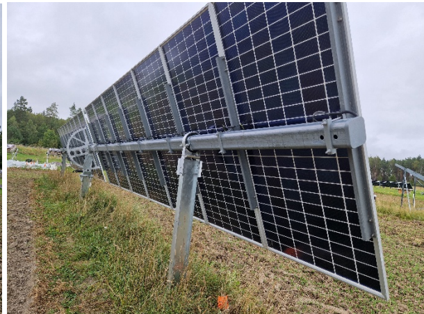
Solcellspaneler upphängda på en horisontell axel och med styrning i en rikning så att de kan följa solens höjd över horisonten. Studerade av MDU och SLU i samarbete.
