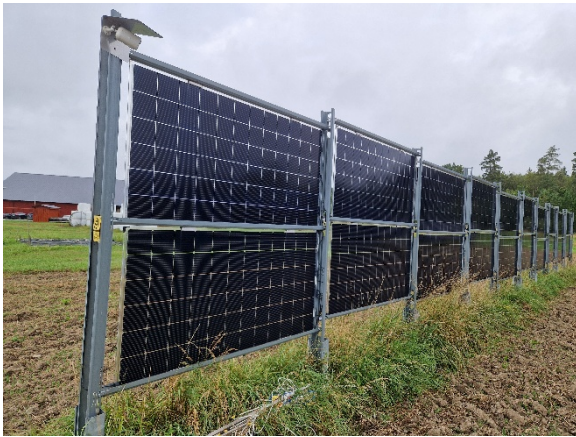
Två-sidiga, stående och fast monterade, solcellspaneler som möjliggör att jorden kan brukas emellan dessa. Studerade av MDU och SLU i samarbete.
